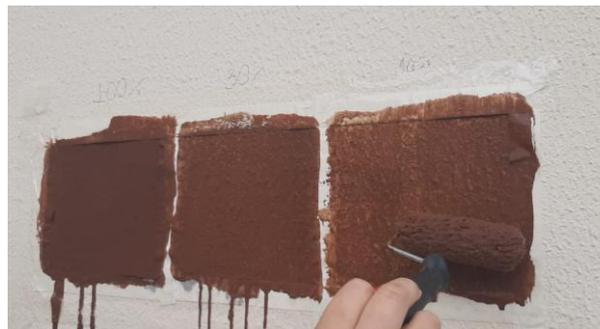
Figura 19 - Aplicação da segunda demão de tinta.
