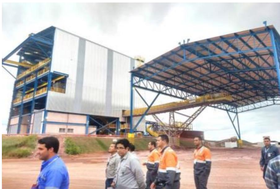
Figura 29. Planta de filtragem e galpão de estocagem
