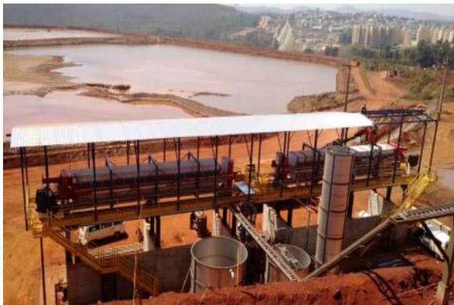
Figura 25. Planta de Filtragem de Rejeitos da Mina Pau Branco
