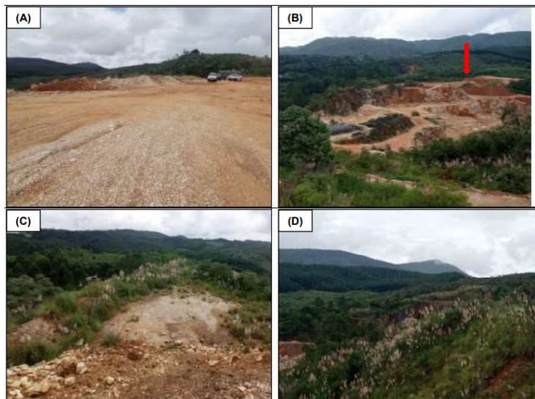
Figura 22 - Na sequência de imagens é possível observar a configuração atual do depósito de estéril 1 (BF-1): vista do piso superior do depósito de estéril (A); posição do Depósito de estéril 1 (BF-1) em relação à área de extração (seta em vermelho) (B); e a configuração dos taludes, onde é possível observar a base do depósito de estéril, já em processo de recuperação (C e D).
