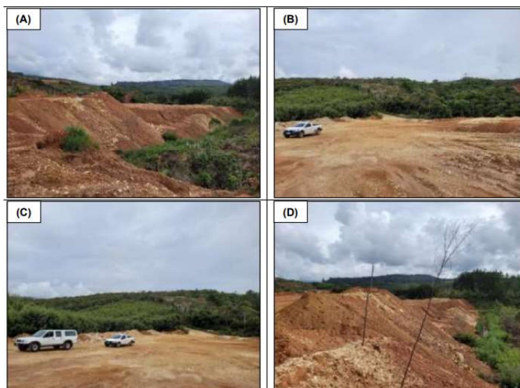
Figura 23 - Vistas da localização e conformação do Depósito de estéril 2 (BF-2) aparentes, bem como a vegetação composta por bracingal que faz limite com o depósito de estéril (B e C); e detalhe da formação do talude do piso superior do depósito de estéril em construção (D).
