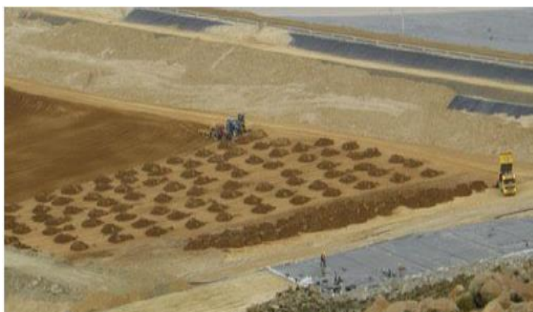
Figura 6 - Formação da pilha de rejeitos filtrados.
