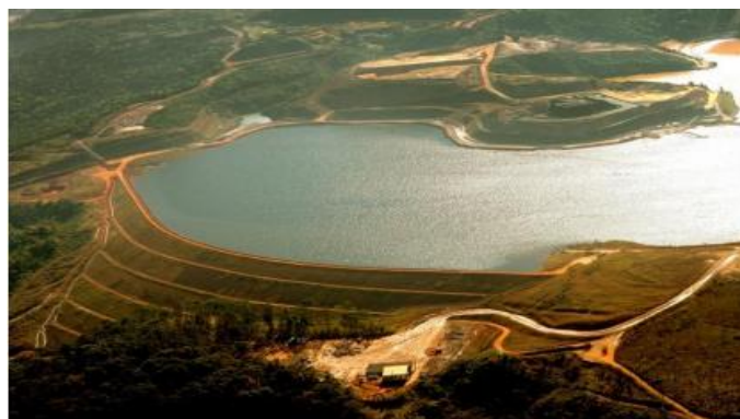
Figura 2 - Barragem de rejeitos.
