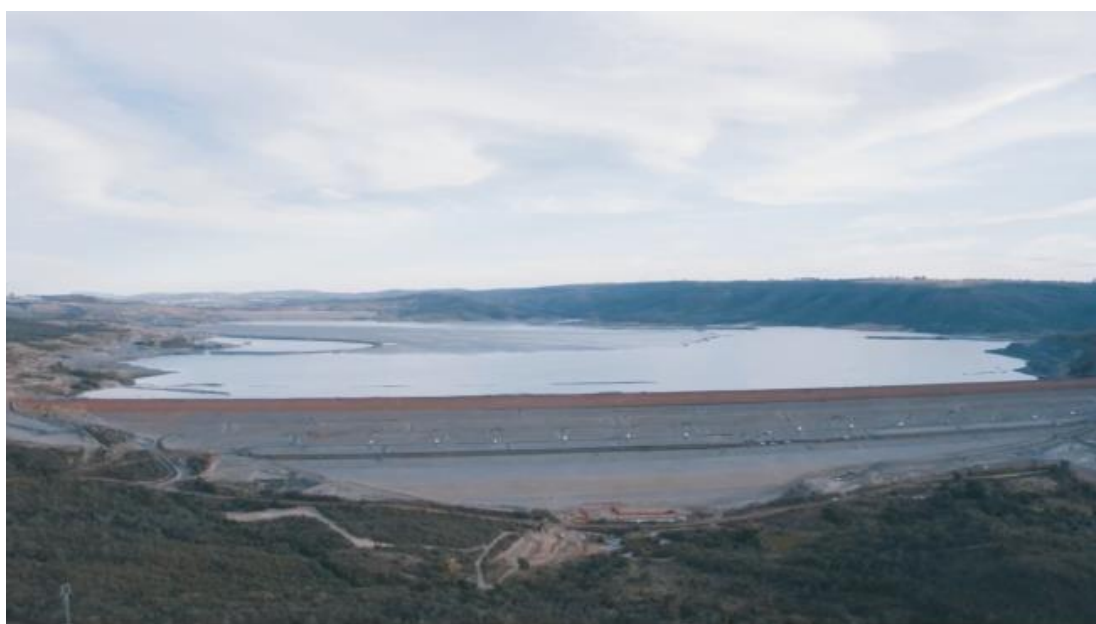
Figura 7: Barragem Eustáquio. Barragem de rejeitos oriundos do beneficiamento de minério de ouro no município de Paracatu/MG.
