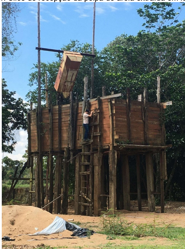
Figura 11: Silos de recepção da polpa de areia extraída em leito de rio.
