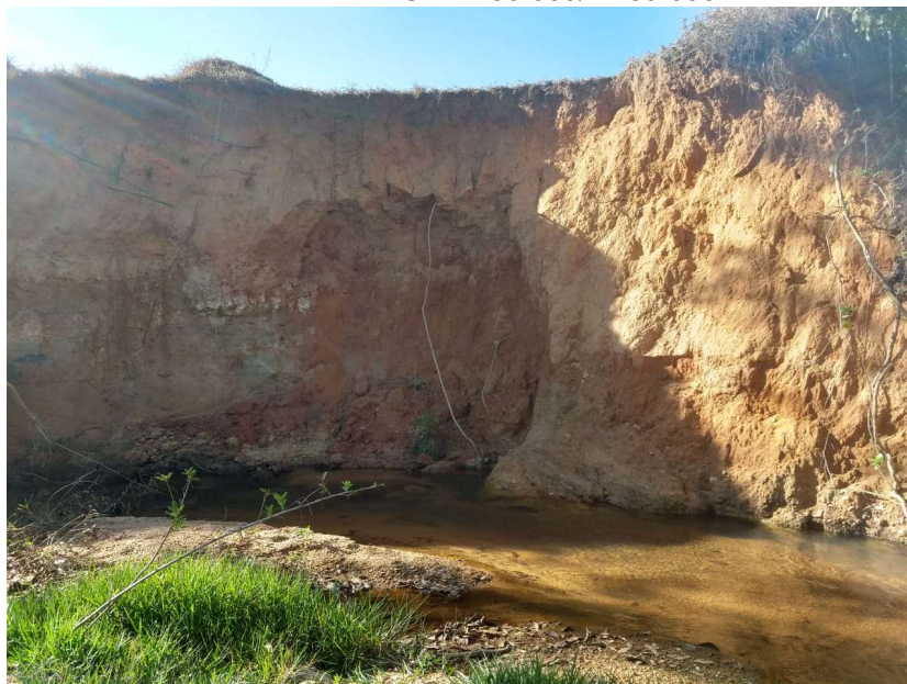
Figura 7: Vista do solo residual de rocha graníticas, margeando o rio entre a seção E1 e E-2, no ponto de coordenada UTM 450.639/7.759.030.
