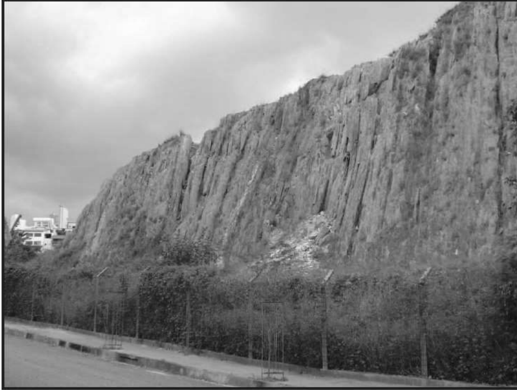
Figura 13 - Vista da face do talude composto pelo maciço de filito, CAS-02.
