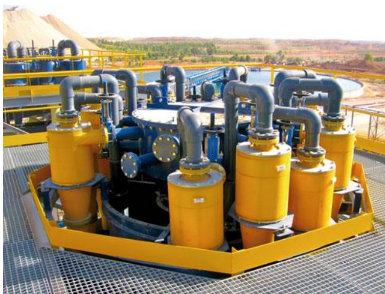
Figura 1: Bateria de hidrociclones.
