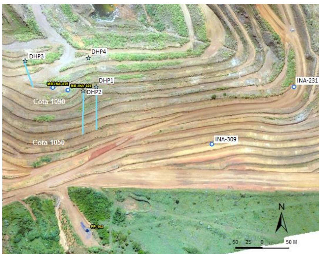
Figura 16: DHP's em operação – frente 2 Fonte: Relatório interno Hidrogeologia 2019
