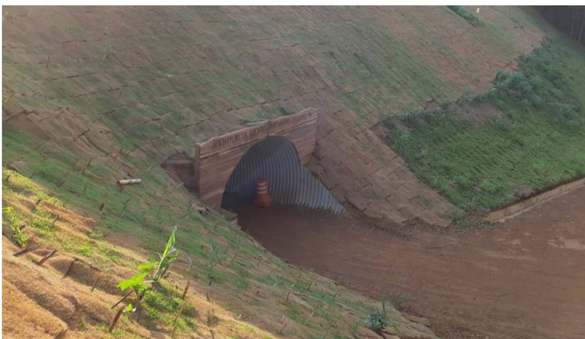
Figura 6: Revestimento do talude com grama esmeralda
