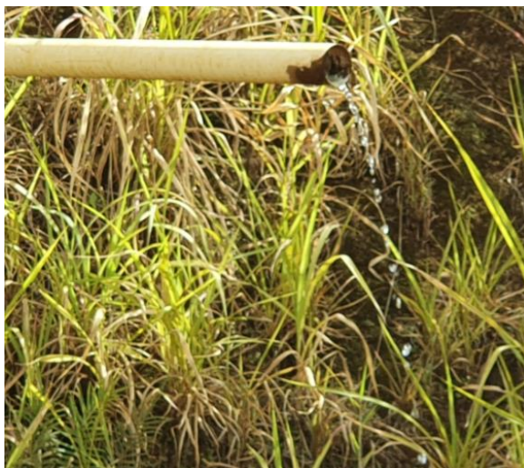
Figura 19: Drenagem água DHP 07 em Julho 2019
