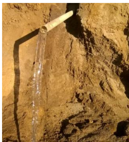
Figura 18: Drenagem água DHP 07 em Julho 2017
