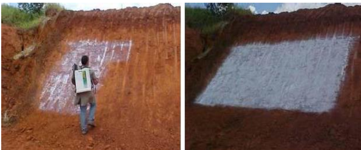
Figura 7: Aplicação de calda fluída de cal com aglutinantes fixadores
