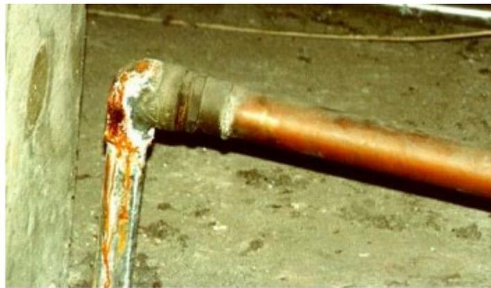
Figura 2.10. Corrosão galvânica entre um tubo de aço galvanizado e o cobre (USP, 2019- B).
