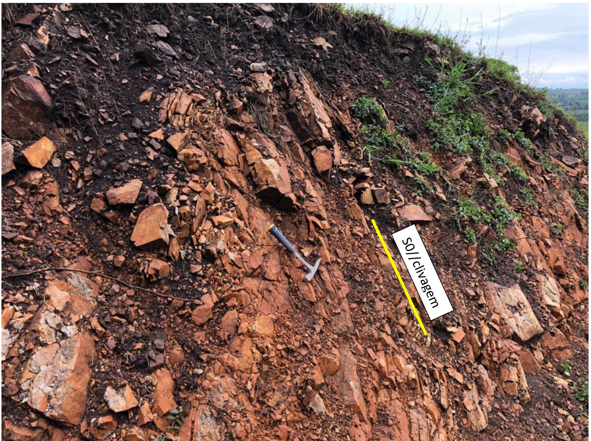
Figura 4. 10 – Quartzito fraturado aflorante em corte de estrada. Notar a forte inclinação do acamamento sedimentar do quartzito (que é paralelo à clivagem; S0//clivagem), devido ao basculamento provocado pela intrusão alcalina.
