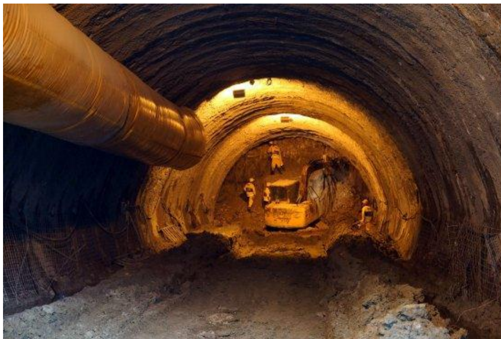
Figura 2 - Alongamento do rio Joana até a Baía de Guanabara, abertura da galeria no formato "Pata de cavalo". (Foto: Portal Cimento Itambé).
