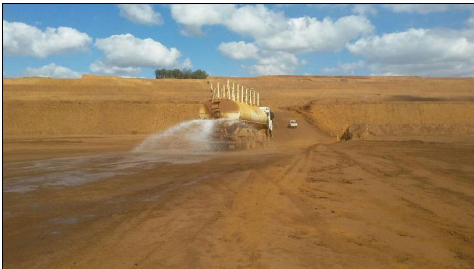
Figura 2-7 - Aspersão das vias através da utilização dos aspersores. Fonte: Autoria própria.
