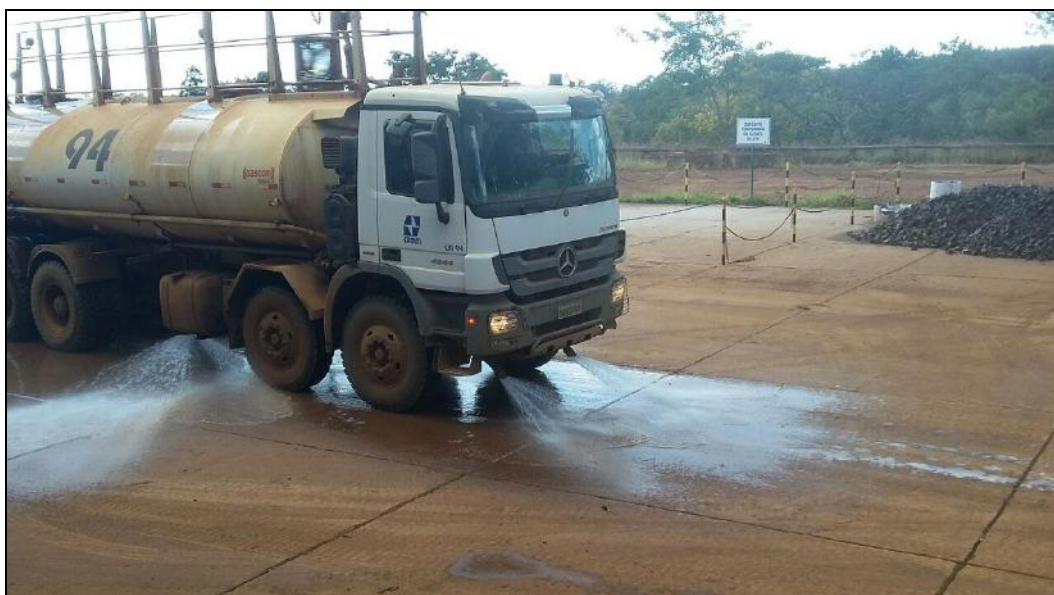
Figura 2-9 - Aspersão através de aspersores frontais e laterais. Fonte: Autoria própria.
