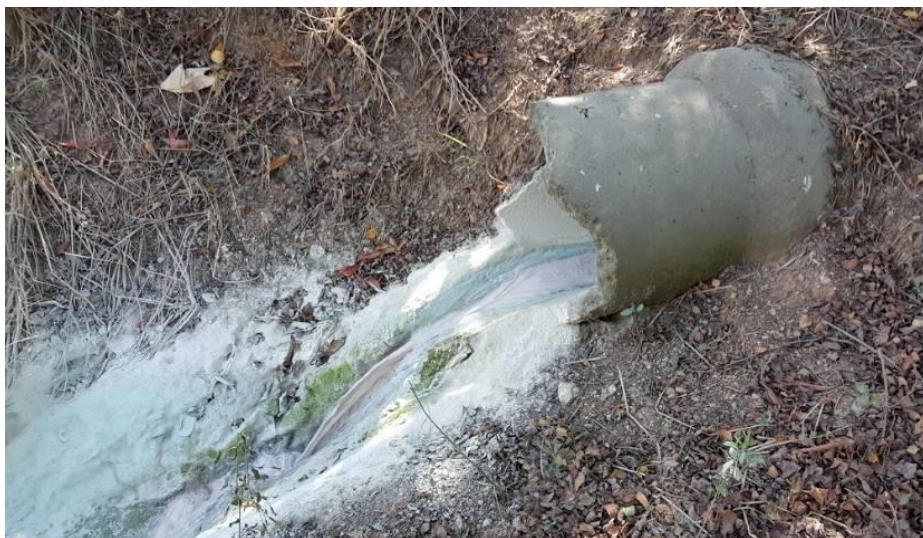
Figura 3.1 – Saída do efluente líquido para a lagoa de decantação
