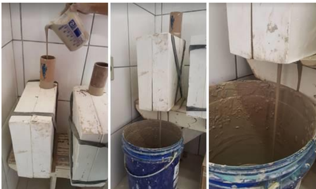
Figura 3.26 – Enchimento, drenagem e detalhe da drenagem na fundição dos cobogós
