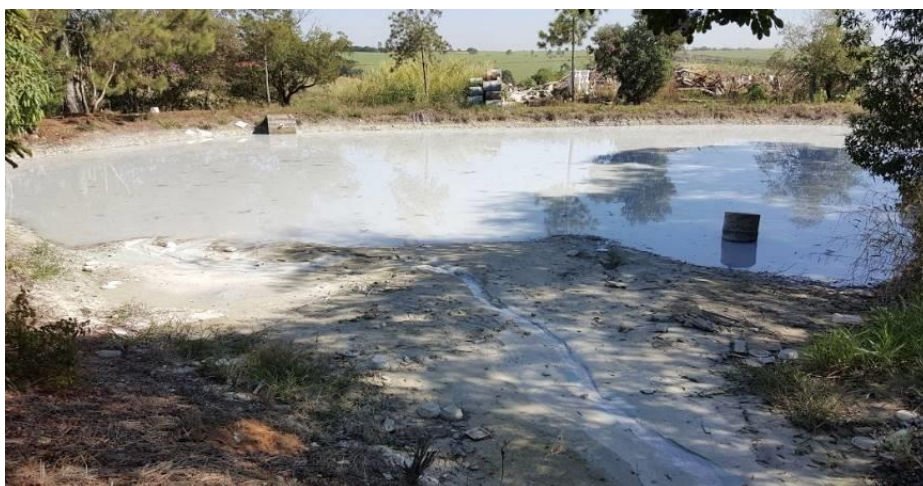
Figura 3.2 – Lagoa artificial de decantação
