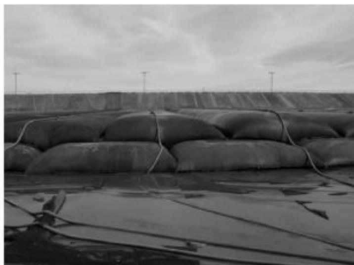
**Figura 2.18 - BAG's desaguadores empilhados em operação. Fonte: Miratech (2005).**
