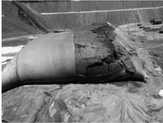
**Figura 2.17 - Polpa desaguada por geotêxteis. Fonte: Newman et al. (2004).**
