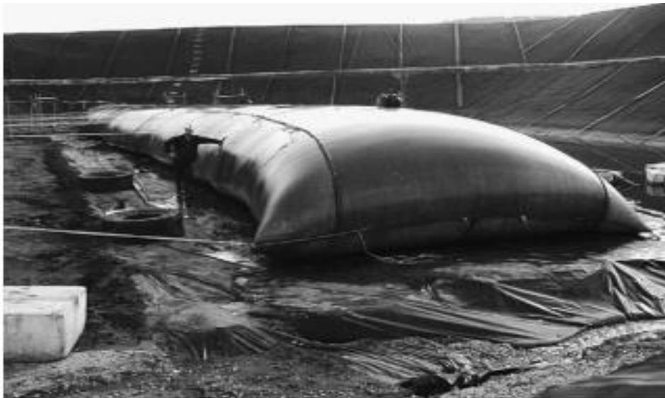
**Figura 2.6 - Tubo desaguador de rejeitos de 60m de extensão. Fonte: Newman et al. (2004).**
