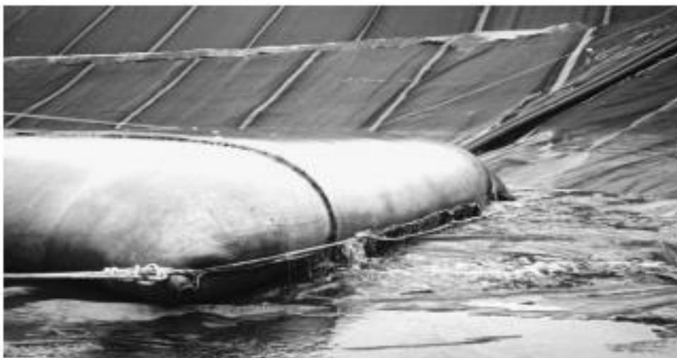
**Figura 2.7 - Desaguamento através de tubo geotêxtil. Fonte: Newman et al. (2004).**
