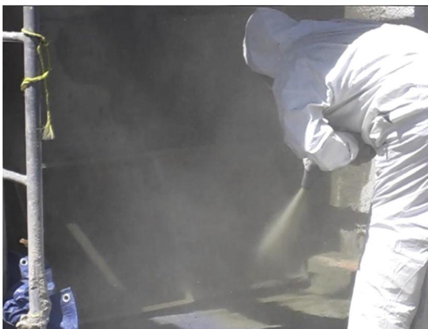
Figura 4.3 - Aplicação do *shotcrete*. Liu *et al.* (2014).
