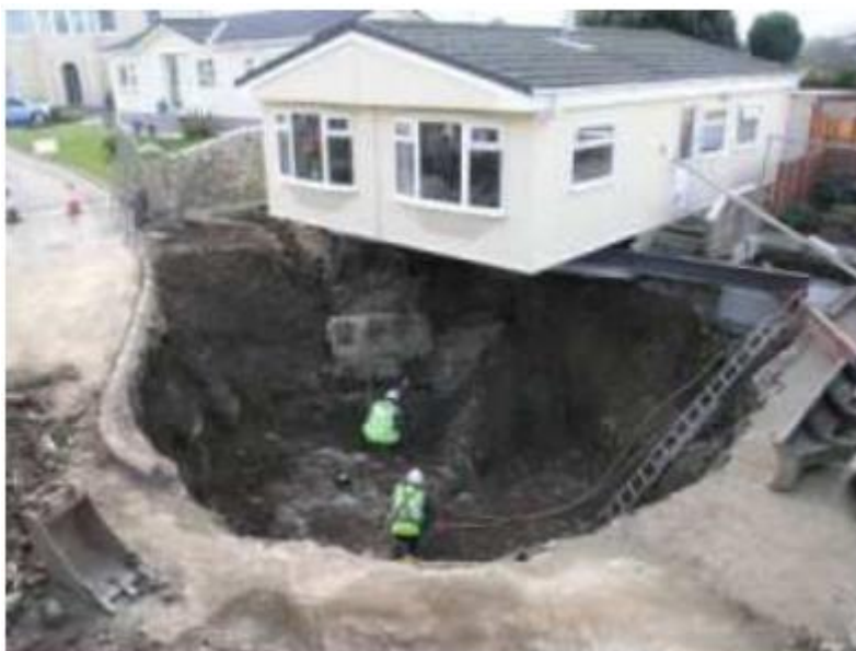
Figura 28 - Subsidência causada por uma perfuração geotérmica.
