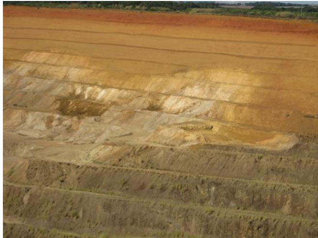
Figura 3.1: Vista frontal da mina de fosfato Fonte: Matos Neto (2013)
