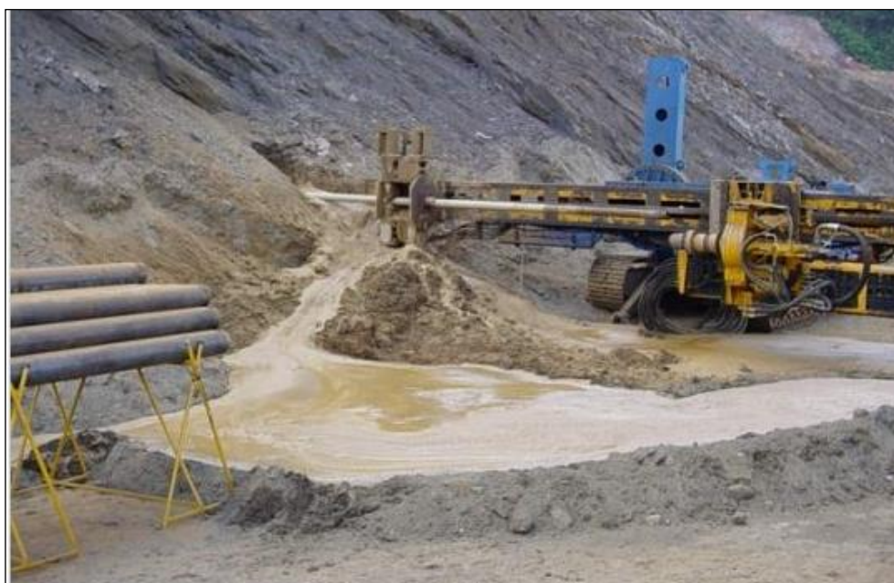
Figura 25 – Perfuratriz realizando um DHP, com limpeza de furo.
