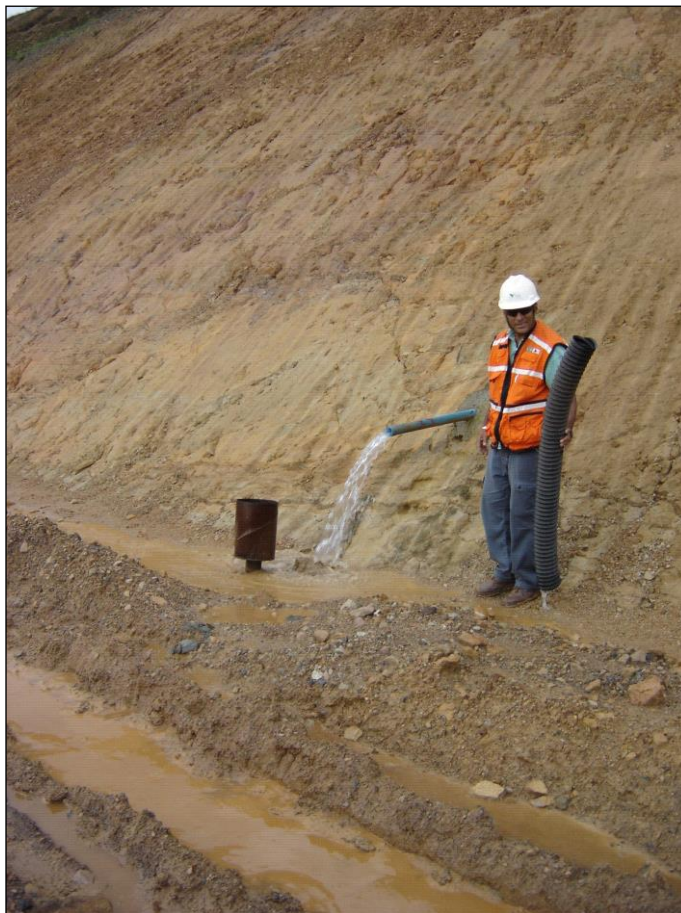
Figura 29 - DHP instalado na Mina de Tamanduá – Nova Lima (MG).
