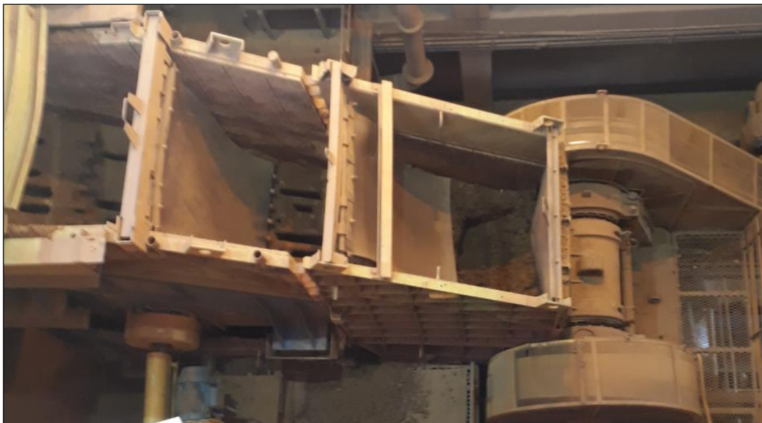
Figura 11 – Obstrução da malha das grelhas, que realizam o escalpe antes do britador de mandíbulas, por material fino de alta umidade.
