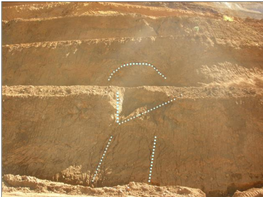
Figura 16 - Fraturamento circular com rompimento em cunha e perpendicular ao talude. Fonte: Arquivo pessoal.
