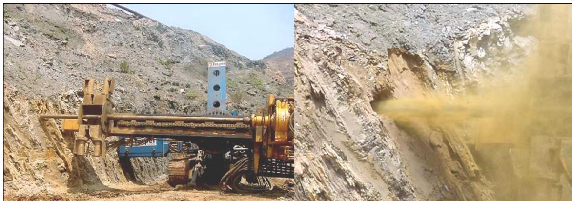
Figura 24 – Perfuratriz realizando um DHP.
