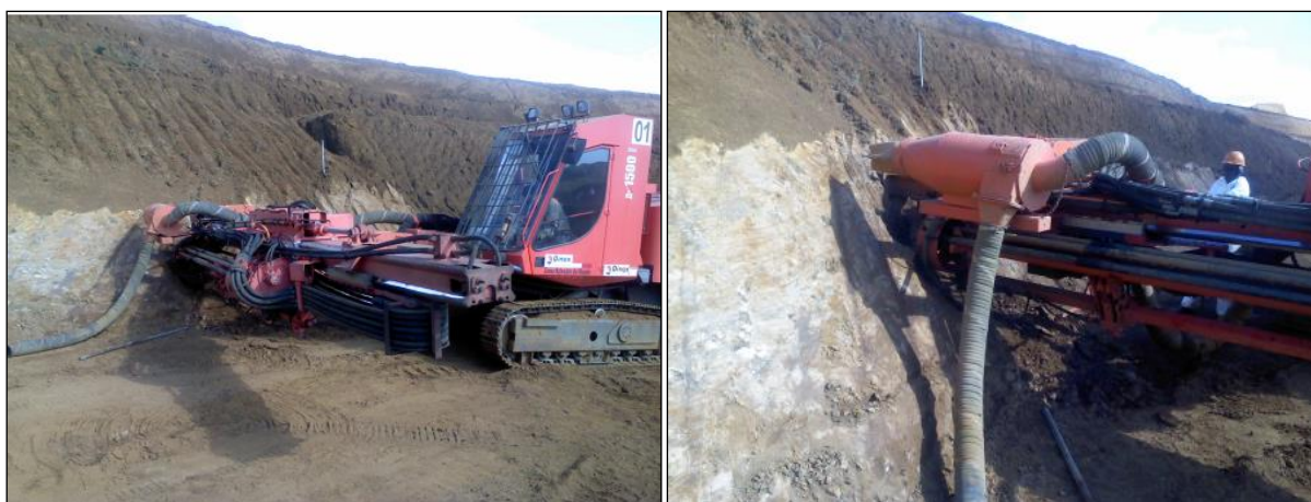
Figura 39 – Perfuração para instalação de drenos horizontais com perfuratriz na mina em estudo.
