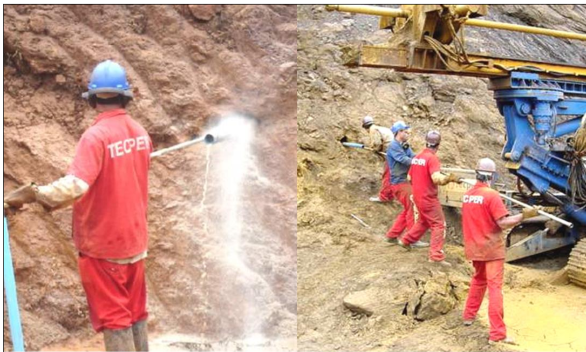
Figura 28 – Injeção de areia selecionada nos DHP's.
