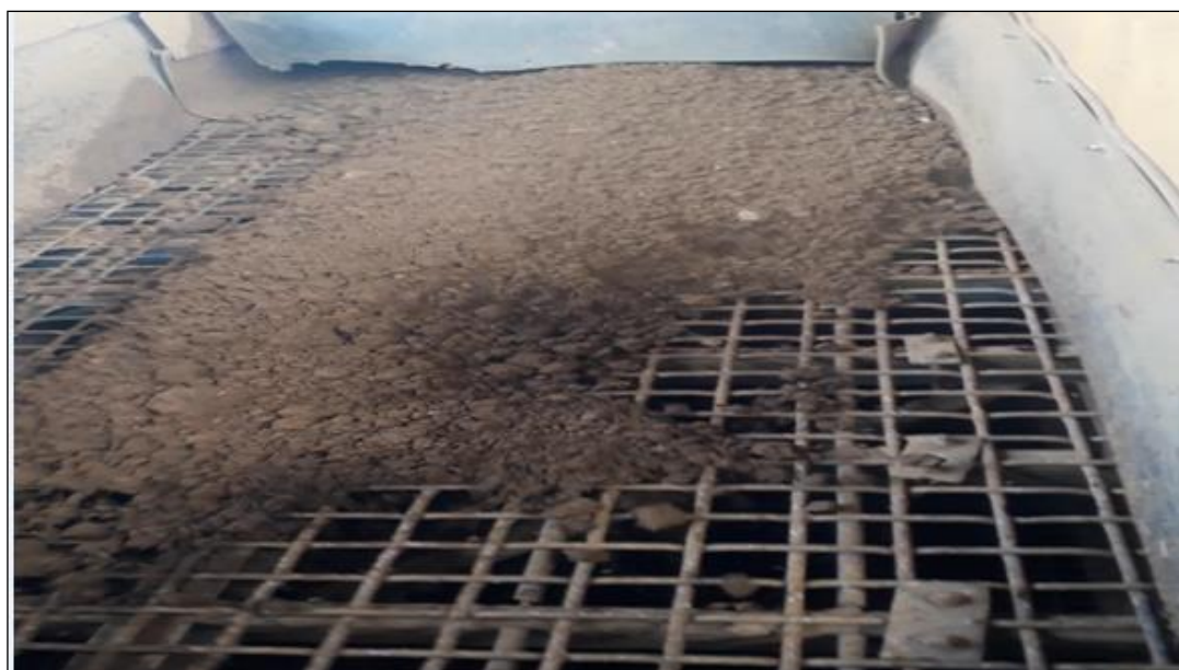
Figura 12 – Material fino com alta umidade agregado ocasionando obstrução da malha das peneiras.
