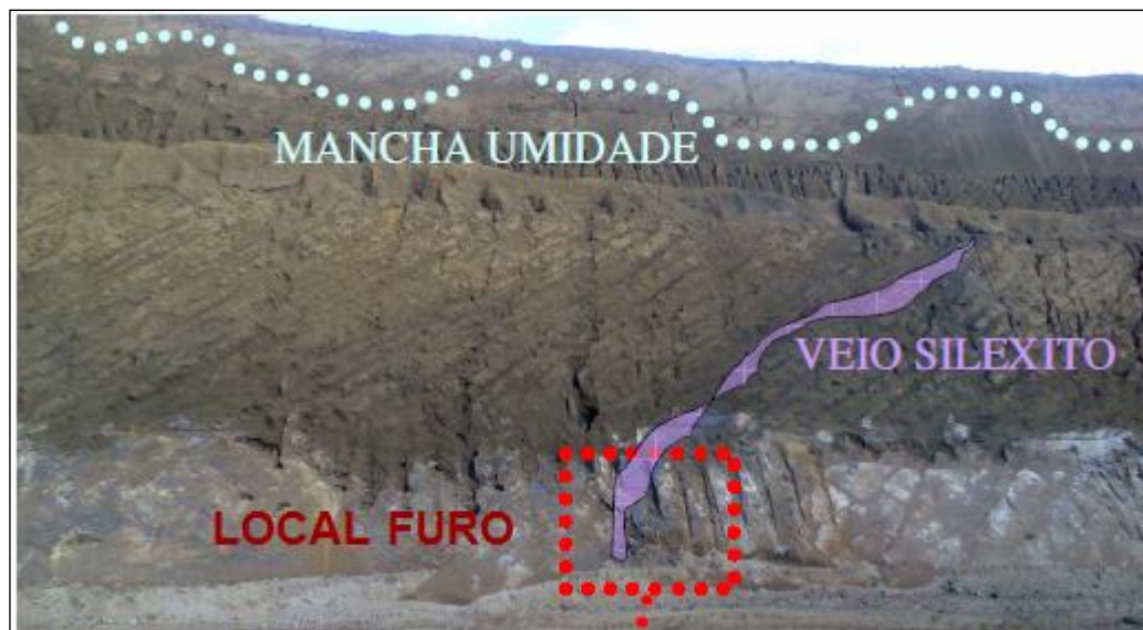
Figura 40 – Talude antes da perfuração dos drenos, detalhe na altura da mancha de umidade.
