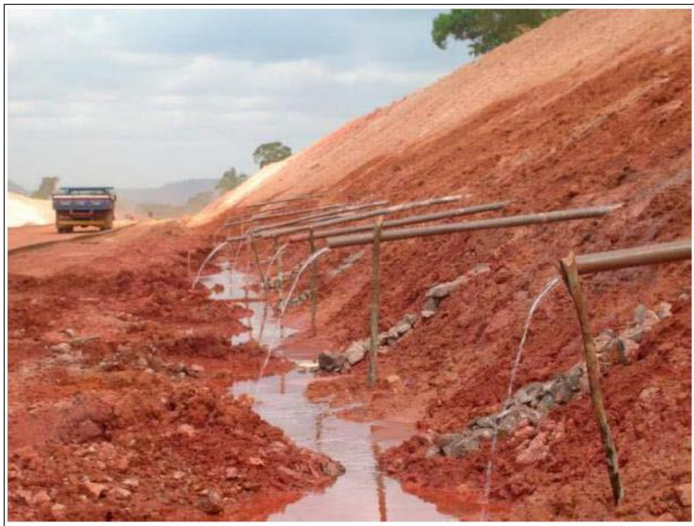
Figura 31 – DHP's instalados em um talude da ferrovia em construção.
