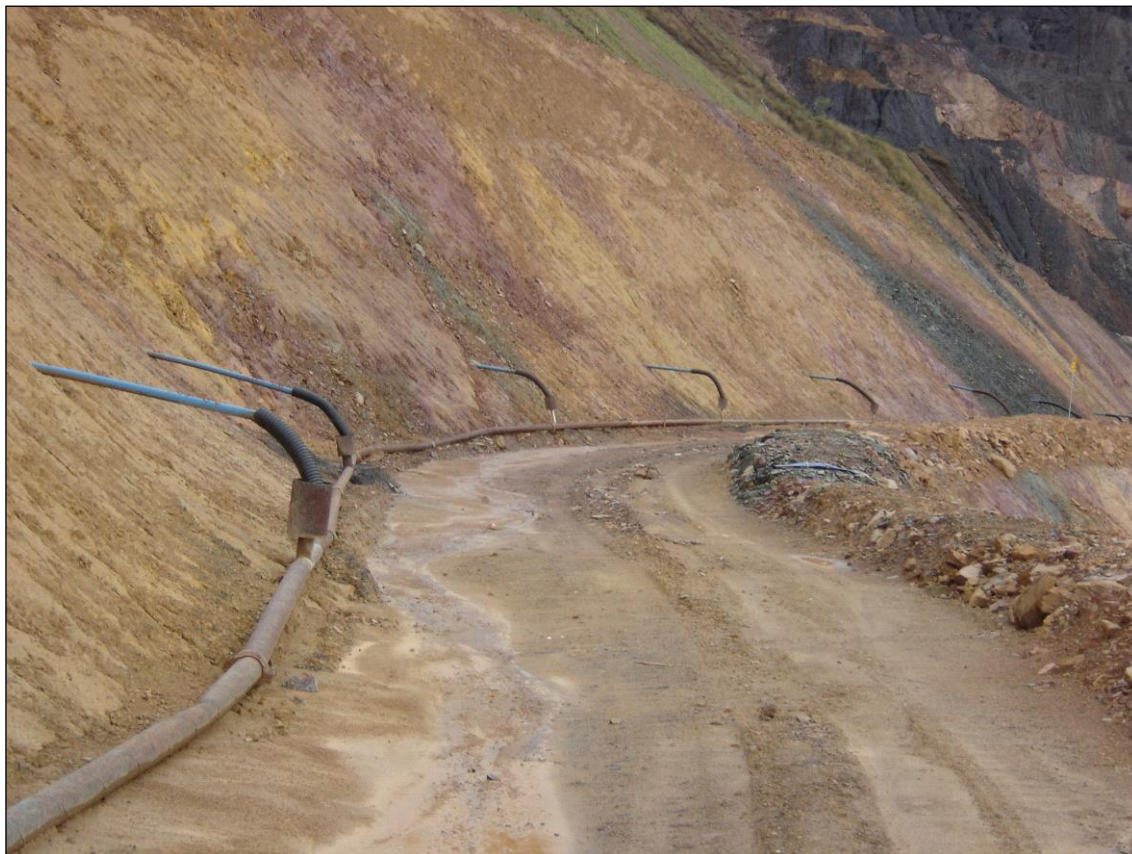
Figura 30 - DHP canalizado.
