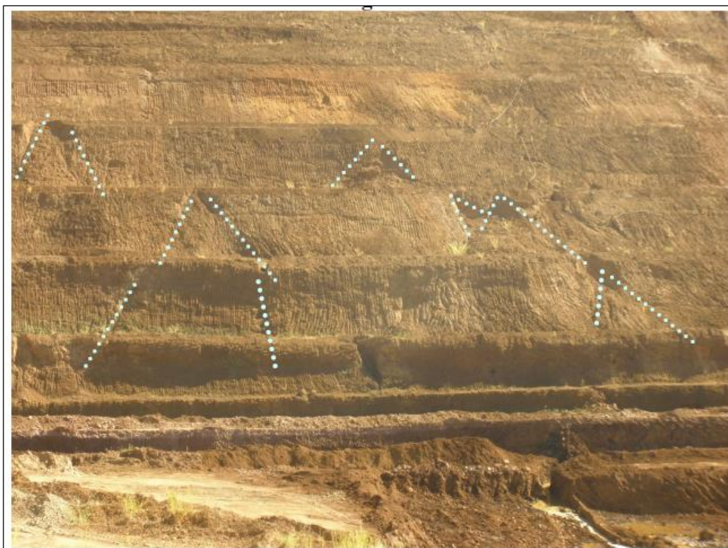
Figura 15 – Material argilo-micáceo com vários rompimentos em cunha promovido pelo próprio fraturamento do material e contribuído pela percolação de água intersticial.
