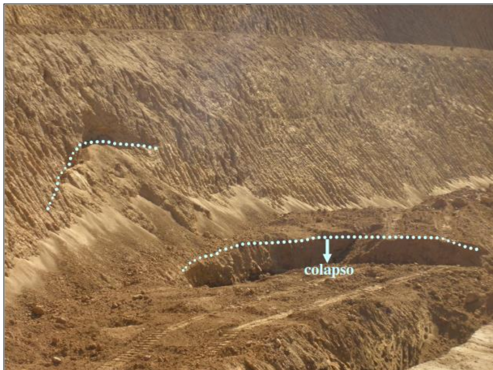
Figura 17 - Fraturamento em cunha com rompimento do talude e ainda rebatimento do piso com quebra do mesmo e colapso devido à percolação de água (material micáceo). Fonte: Arquivo pessoal.
