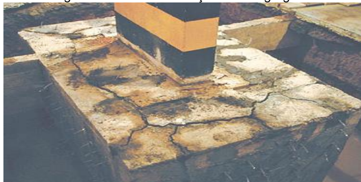
Figura 3.7 – Caso de reação álcali-agregado.
