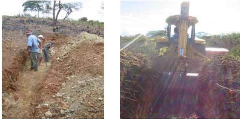
Figura 2.2 - Trincheiras abertas manualmente e mecanicamente (NETO 2010).
