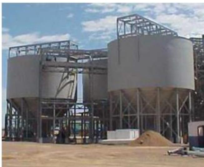
Figura 2.5 – Espessador de alta capacidade
