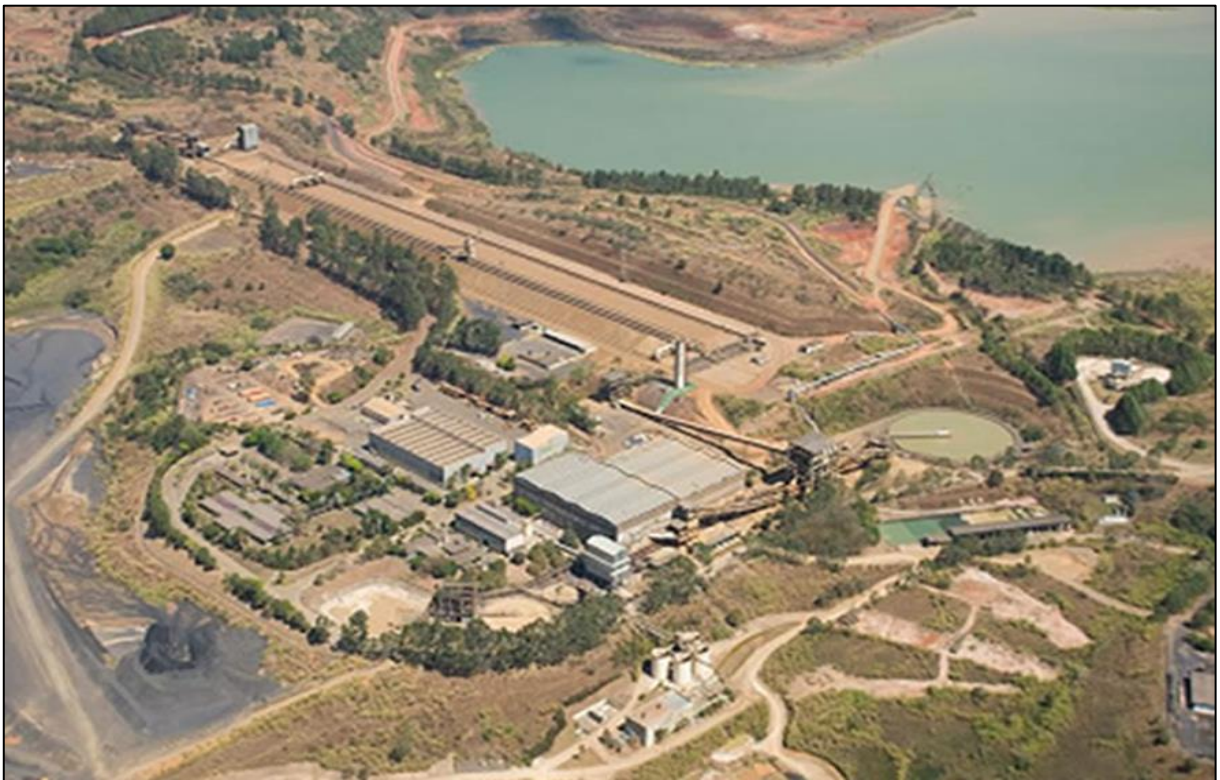
Figura 20 – Visão panorâmica do Complexo de Mineração de Tapira.
