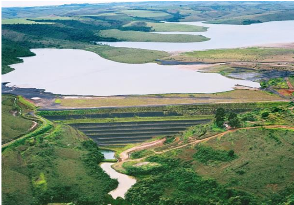
Figura 9 – Barragem de rejeitos.
