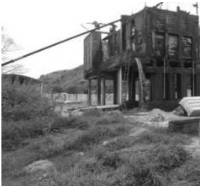
Figura 2 –Silos de recepção da polpa bombeada do leito do rio. Fonte: Almeida & Luz, 2012.
