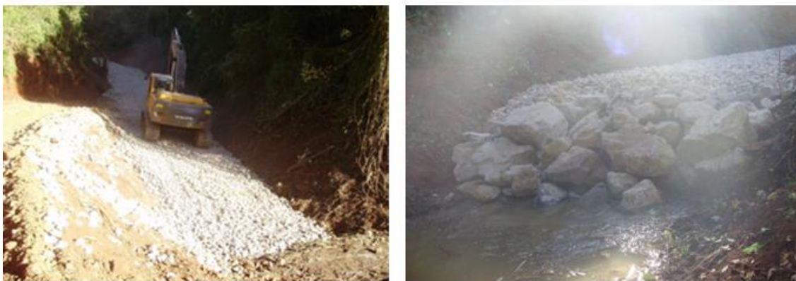
Figura 3: Drenagem de fundo em uma pilha de estéril.
