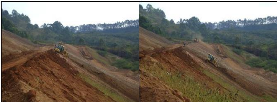
Figura 12: Etapa de retaludamento com trator de esteira.
