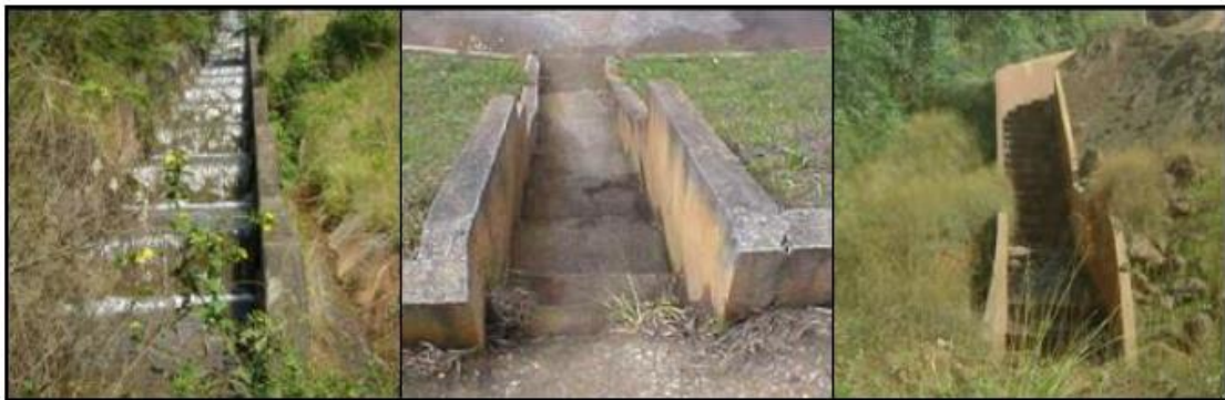
Figura 6: Exemplo de sistema de drenagem superficial - descidas d'água.
