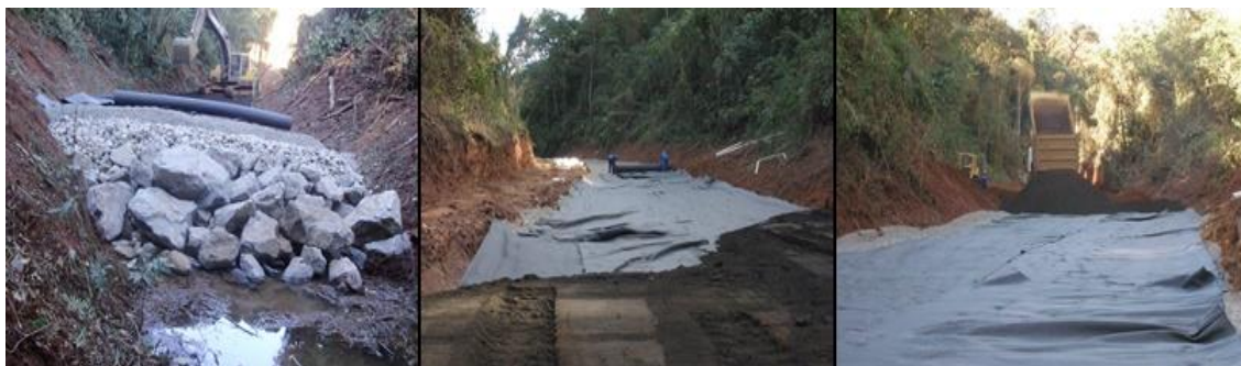
Figura 4: Tapete drenante e disposição do estéril acima do mesmo.
