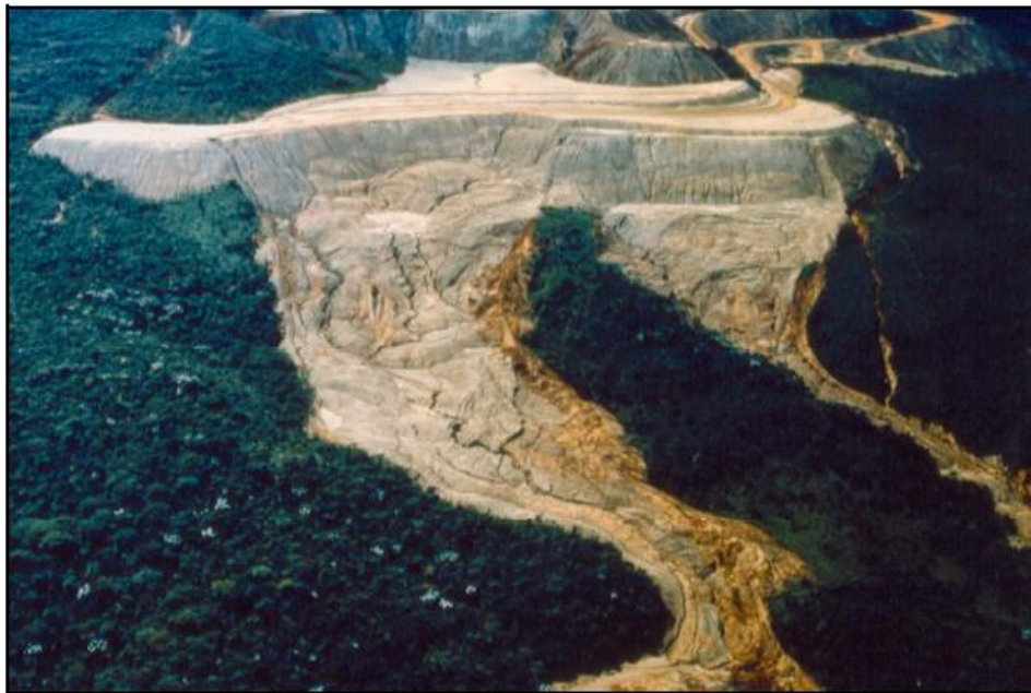
Figura 8: Exemplo de ruptura em pilha de estéril.
