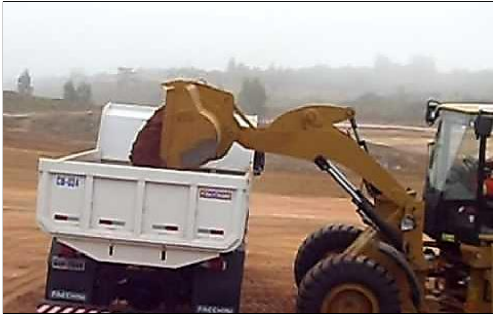
Figura 58 - Altura de impacto do material Fonte: vídeo youtube Pá carregadeira Caterpillar 924Hz
